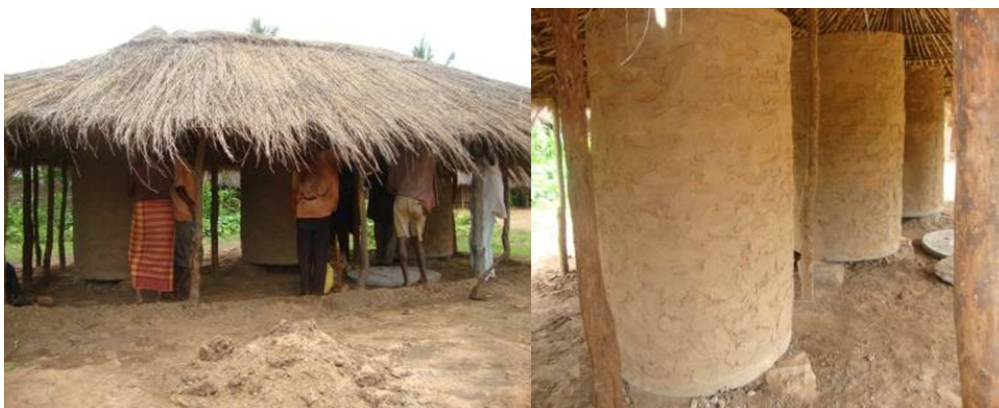
Figura 23. Celeiro tipo gorongosa para conservação pós colheita da semente
